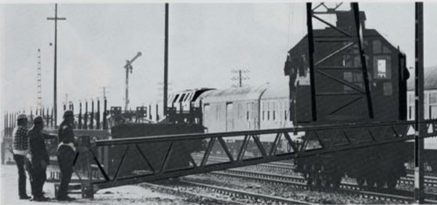
Die ersten Maste im Bahnhof Ortenberg (Abschnitt Offenburg — Hausach)
