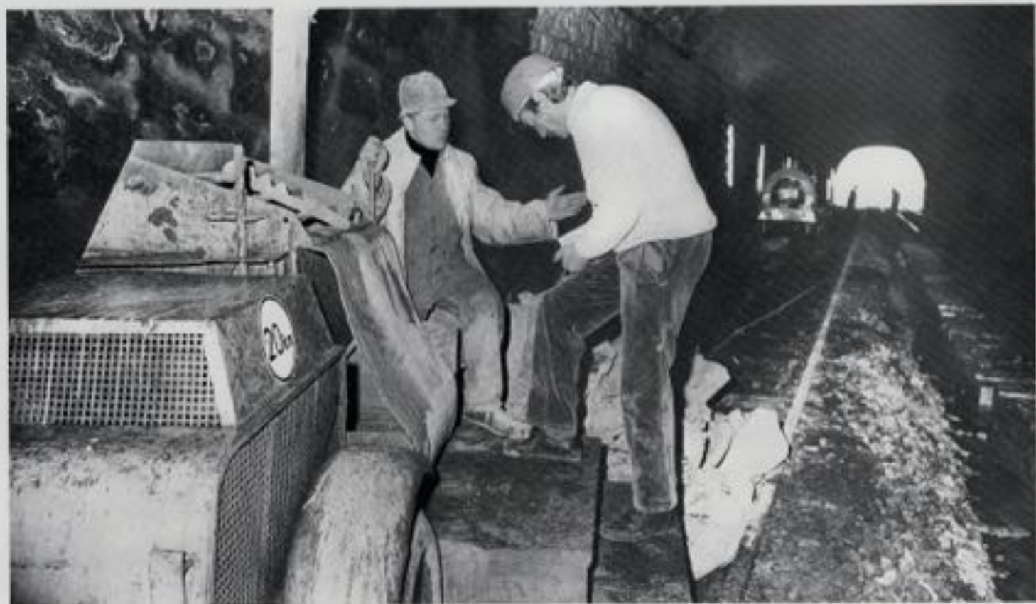
Mischmaschine für die Zementinjektionen
