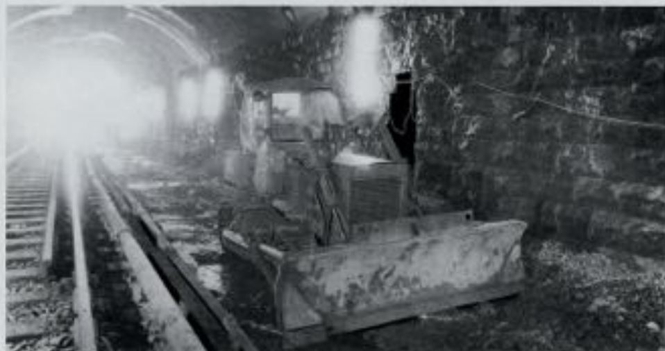
Planierdraupe für die Absenkarbeiten
