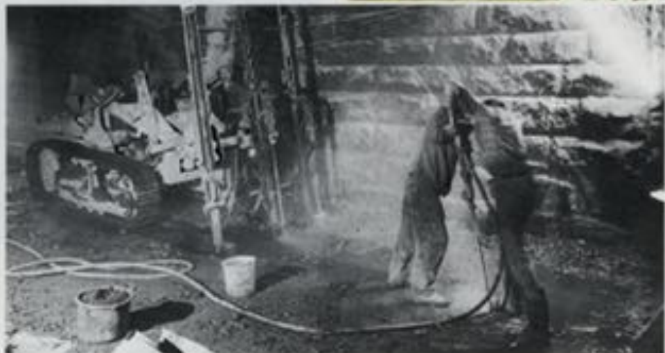
Bild 4 Bohren der Sprenglöcher
