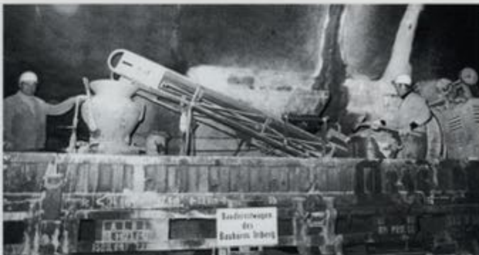
Abdichtungsarbeiten im Tunnel
