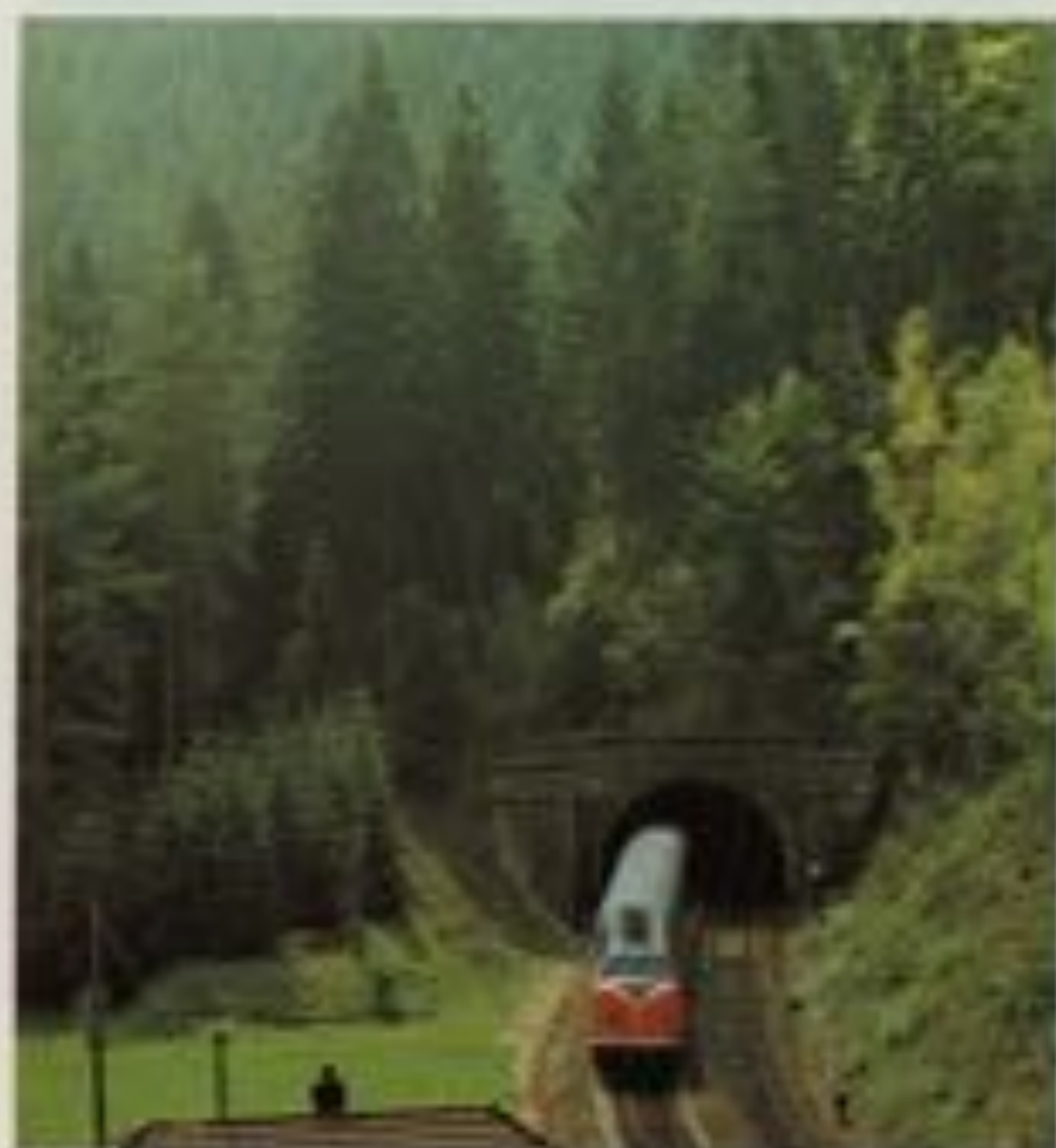
Ausfahrt aus dem Spärletunnel
